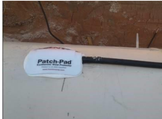
GASODUCTO 24" GSCY KM-19 EXPORT LINE
